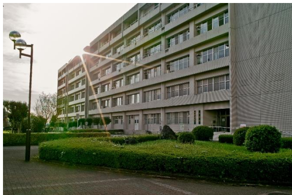
改修工事前の宮崎大学工学部 A 棟外観
