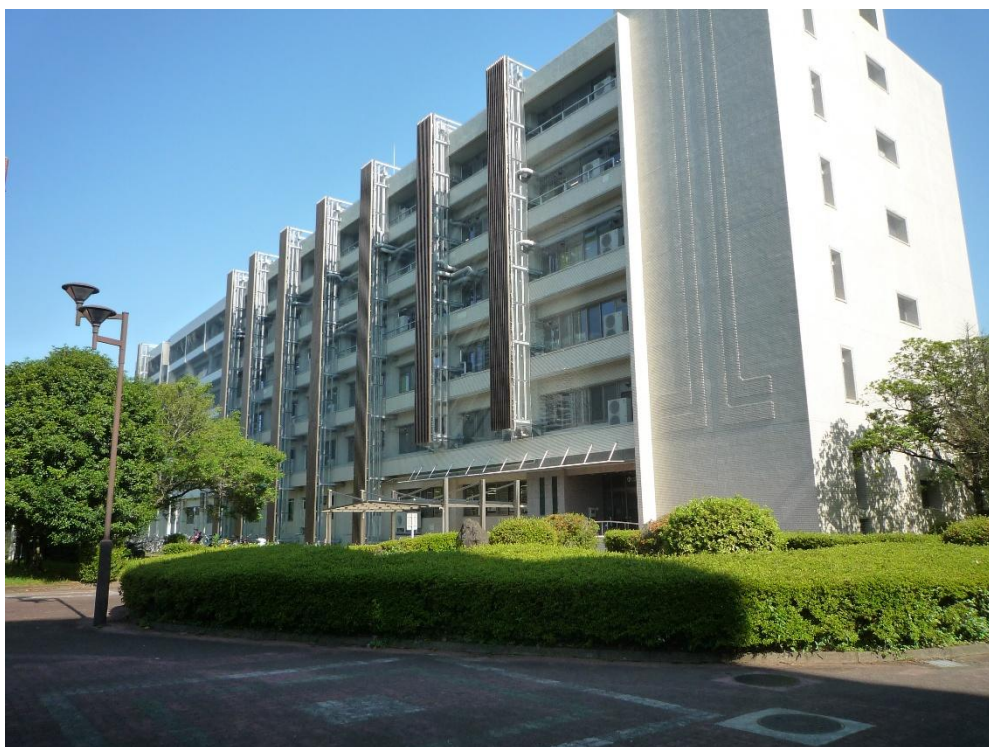
改修工事後の宮崎大学工学部 A 棟外観
